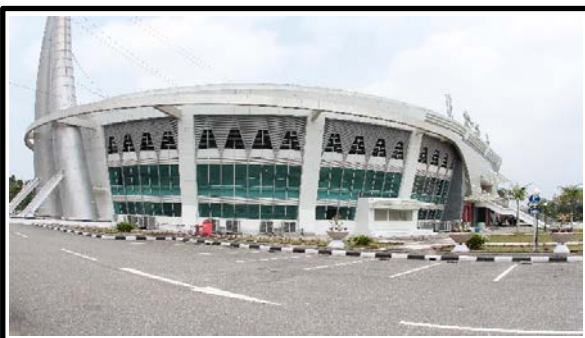
TAMPAK SAMPING (KANTOR BAPENDA)
