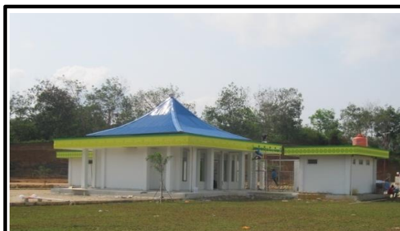
MUSHOLLA DAN RUANG GENSET
